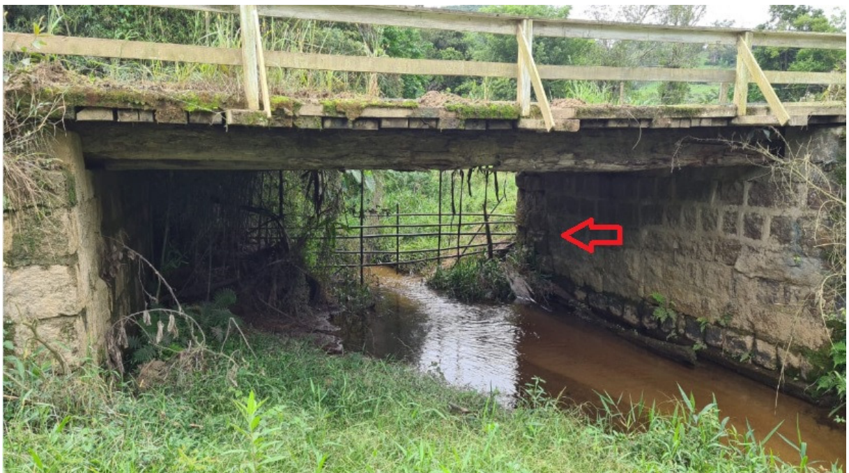
Imagem 2 – Vista da estrutura da ponte e linha de cisalhamento da estrutura
