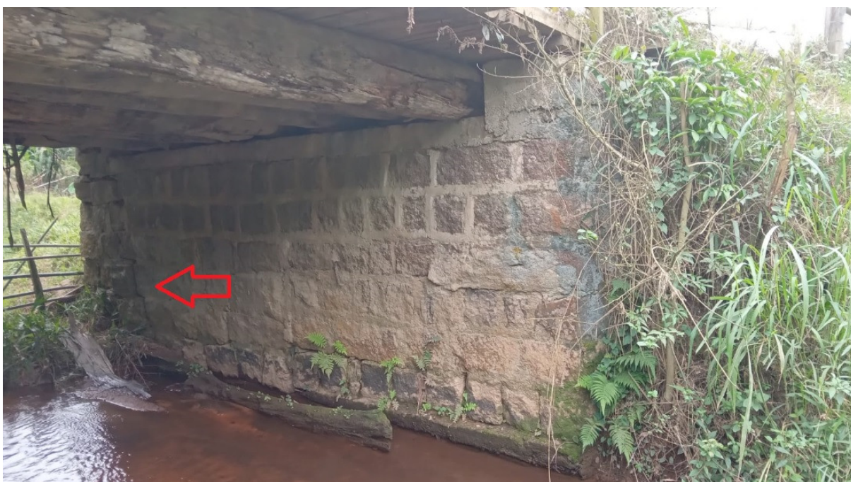
Imagem 1 – Linha de cisalhamento na estrutura da cabeceira.
