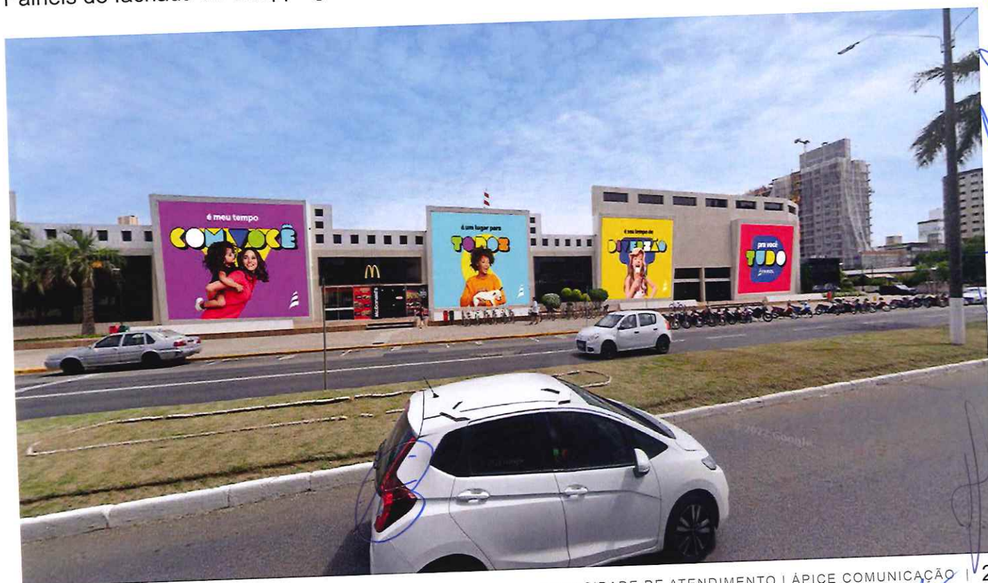
Painéis de fachada do Shopping
