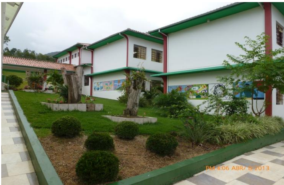
Abrigo 3: E.E.B. Martinho Alves dos Santos, Rua José Alves dos Santos Passos (ao lado da Igreja São Martinho), Bairro São Martinho. Fonte: Proteção e Defesa Civil, 2014.
