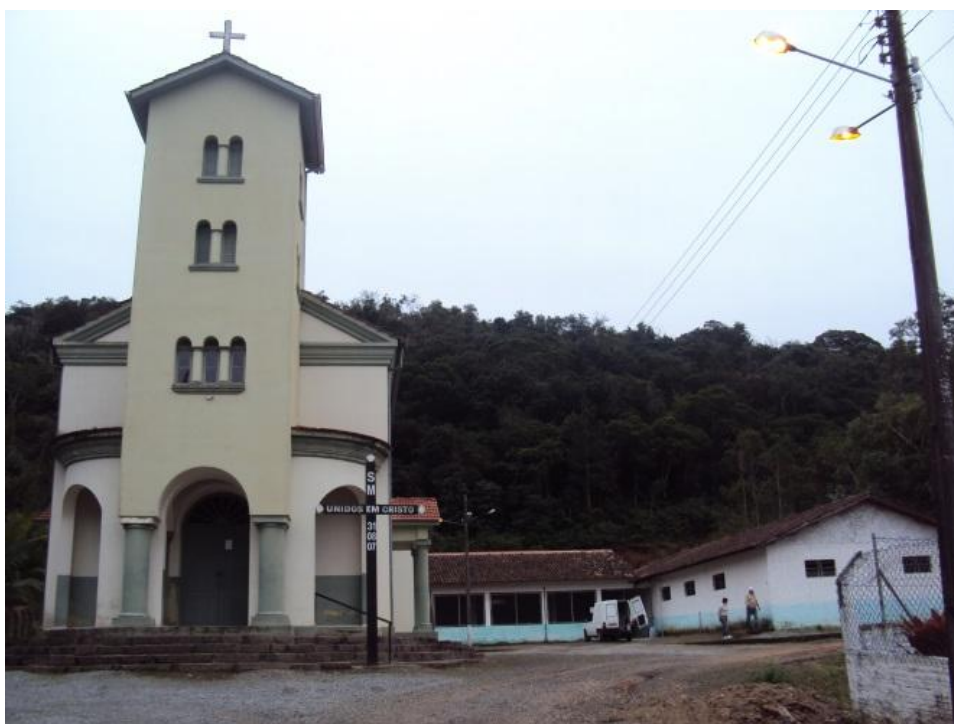
Abrigo 9: Igreja e Salão Paroquial Nossa Senhora da Saúde, Estrada Geral da Guarda (Margem Esquerda), Bairro Guarda. Fonte: Proteção e Defesa Civil, 2014.
