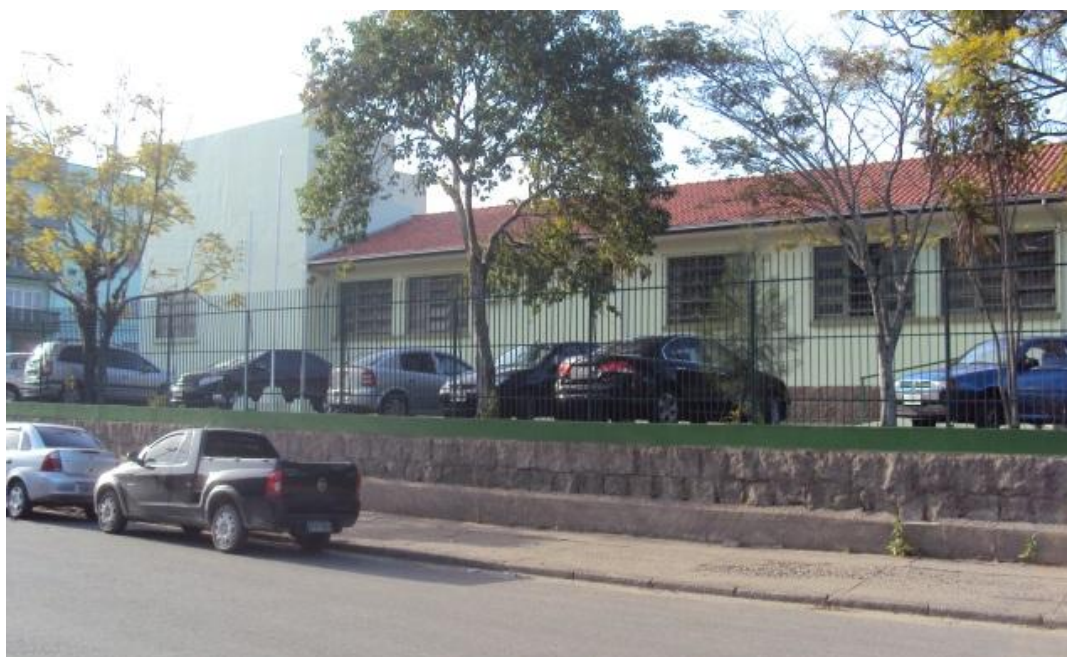
Abrigo 20: E.E.B Henrique Fontes, Avenida Patrício Lima, Bairro Centro. Fonte: Proteção e Defesa Civil, 2014.
