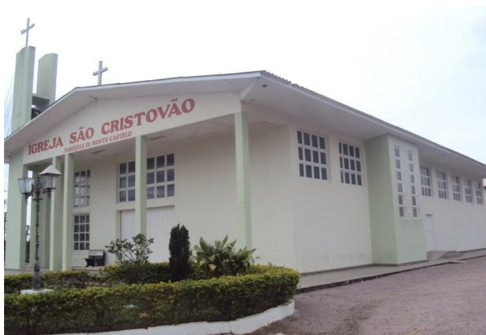
Abrigo 14: Igreja e Salão Paroquial do São Cristóvão, Rua José Botega Bairro São Cristóvão. Fonte: Proteção e Defesa Civil, 2014.
