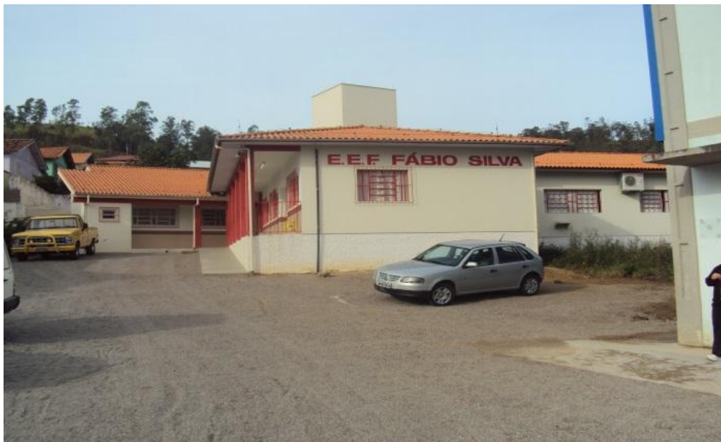
Abrigo 11: E.E.F. Fábio Silva, Rua Marechal Deodoro da Fonseca, Bairro Fábio Silva. Fonte: Proteção e Defesa Civil, 2014.
