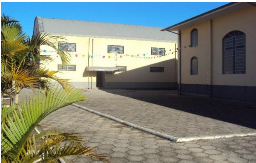
Abrigo 4: Igreja e Salão Paroquial São João Batista, Rua São João s/n, frente a E.E.B. Célia Coelho Cruz, Bairro São João, Margem Esquerda. Fonte: Proteção e Defesa Civil, 2014.
