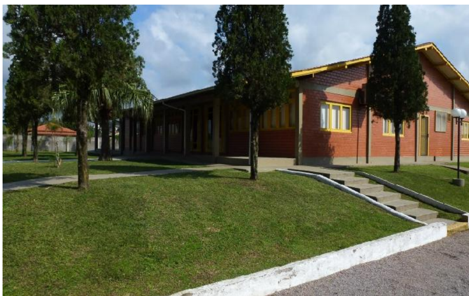
Abrigo 26: Associação dos Ferroviários, Rua José Pedro Lisboa, Bairro Monte Castelo. Fonte: Proteção e Defesa Civil, 2014.
