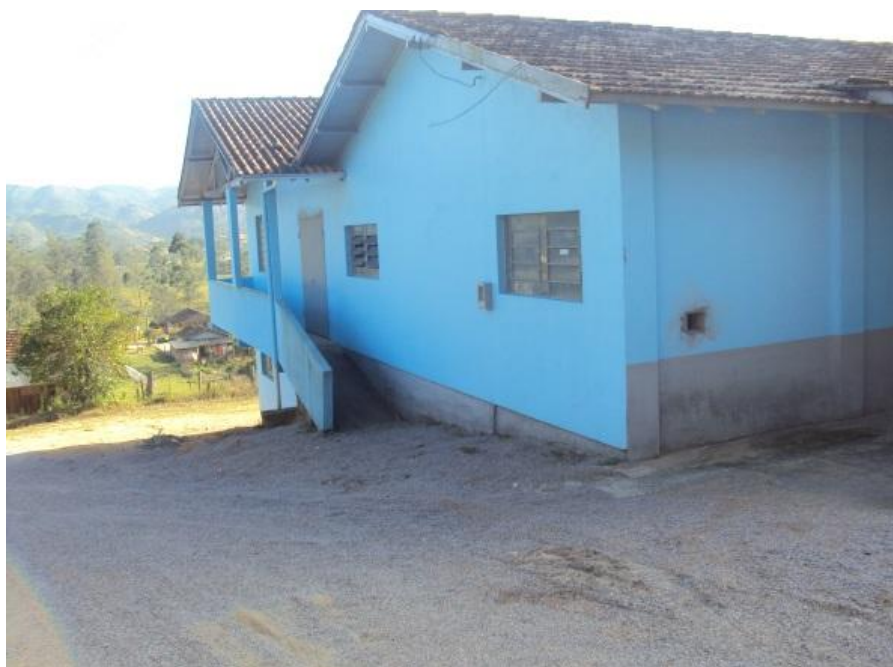
Abrigo 24: Igreja e Salão Paroquial Nossa Senhora Aparecida - Gruta, Estrada Geral do Sertão da Jararaca, Bairro Jararaca. Fonte: Proteção e Defesa Civil, 2014.
