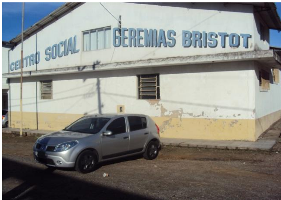
Abrigo 15: Centro Social Geremias Bristót, Rua Raul Claudino Soares s/nº Bairro Monte Castelo. Fonte: Proteção e Defesa Civil, 2014.
