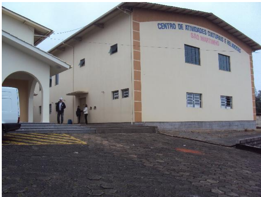
Abrigo 1: Igreja e Salão Paroquial São Martinho, Rua José Alves dos Santos Passos, Bairro São Martinho. Fonte: Proteção e Defesa Civil, 2014
