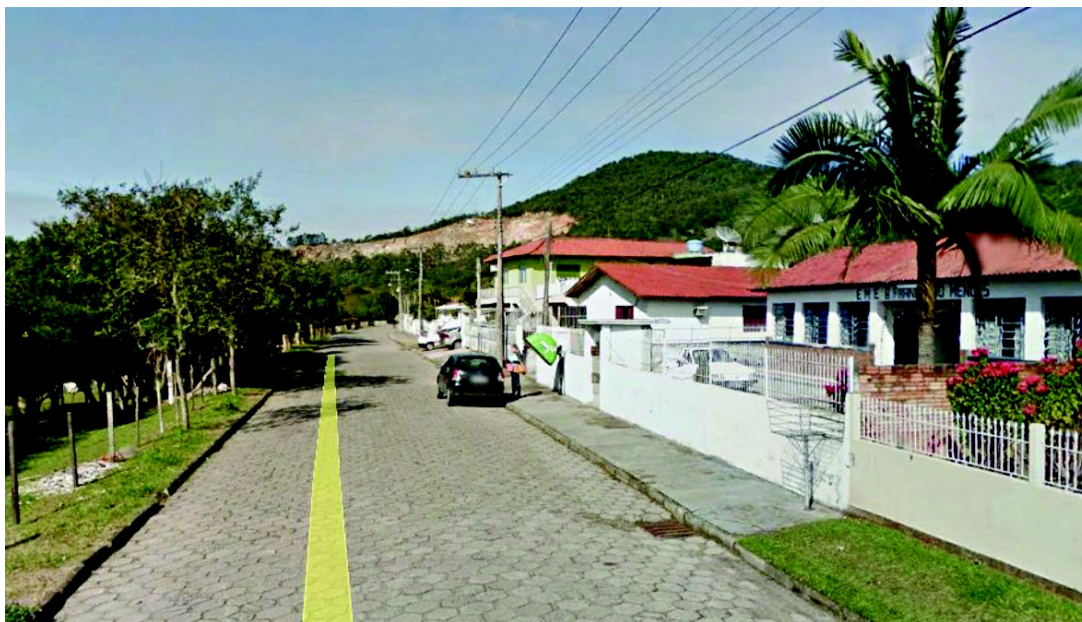
Local de Implantação - Rua José Venâncio Fonte: Google Maps. Acesso em: 30 ago. 2017.
