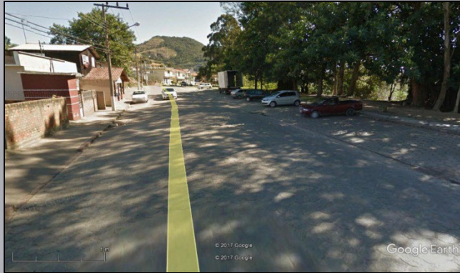
SITUAÇÃO EXISTENTE 1º TRECHO (LAJOTA)
