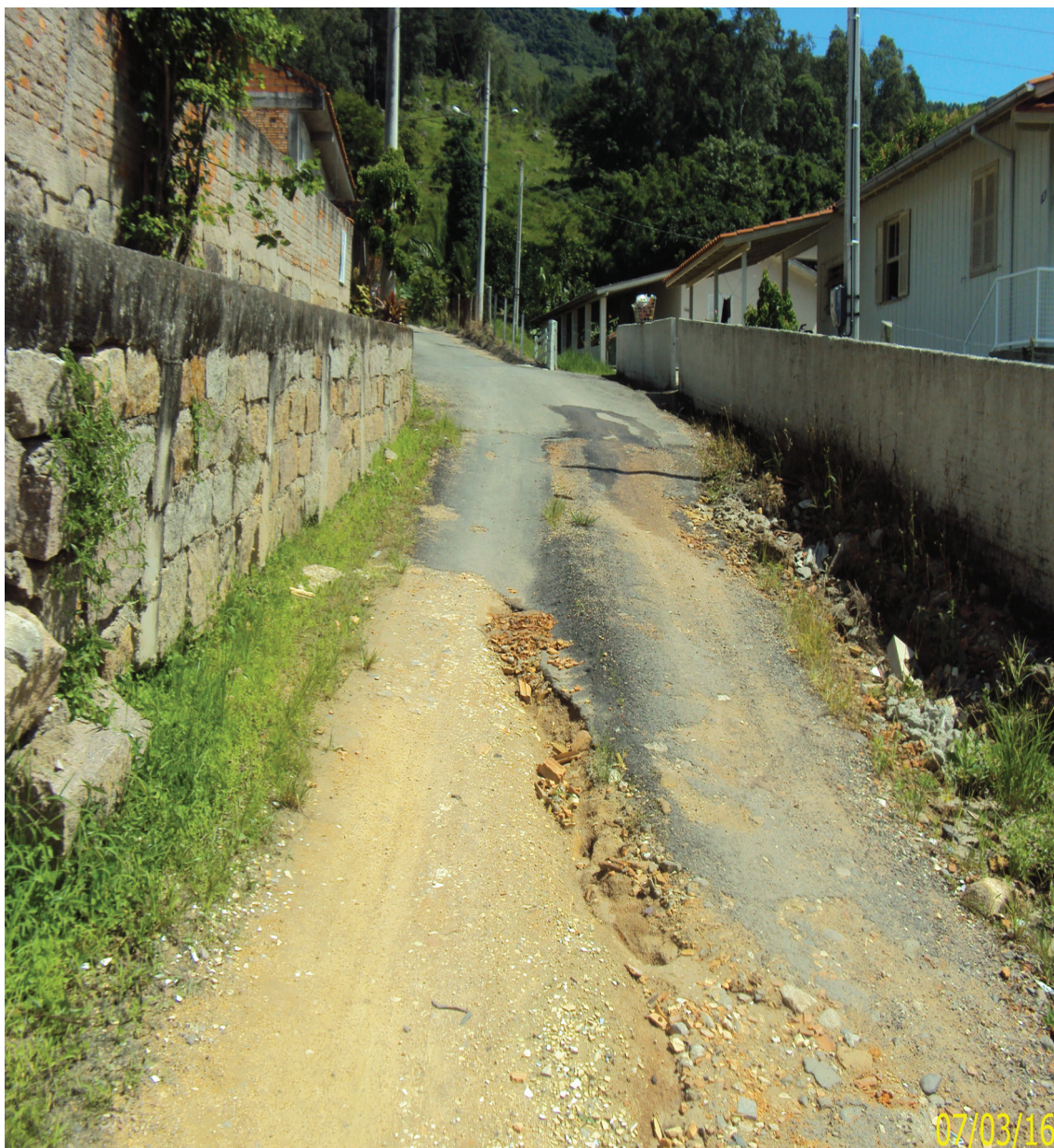
Imagem 05 – Vista da Rua José Nunes Frederico – início do pavimento existente
