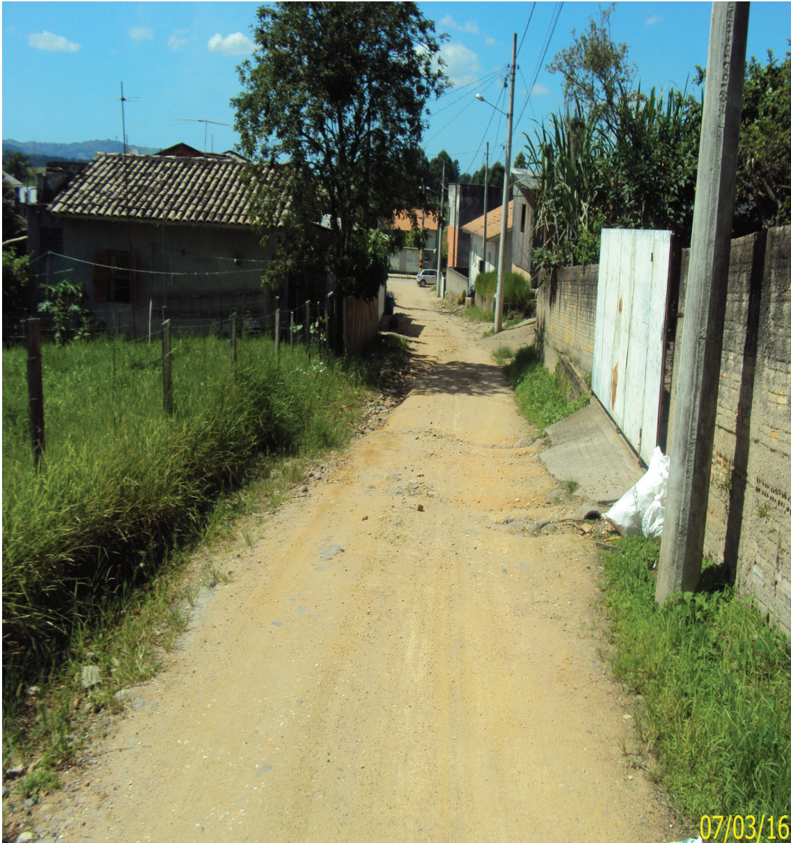
Imagem 04 – Vista da Rua José Nunes Frederico – início do pavimento existente
