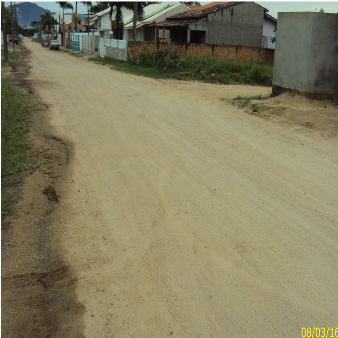
Imagem 05 – Vista do final do trecho a ser pavimentado da Rua Manoel Tobias
