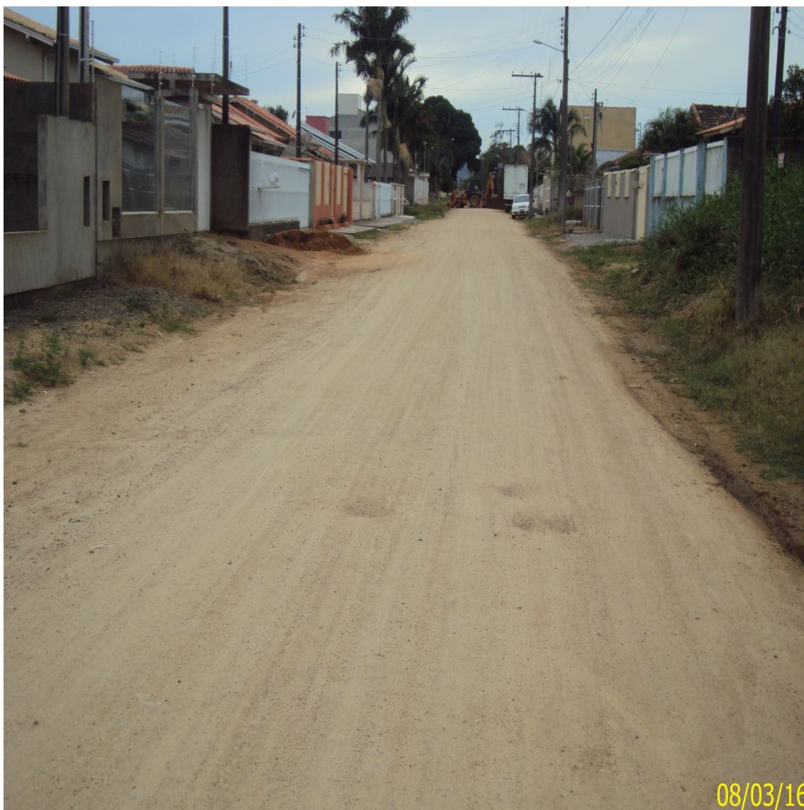
Imagem 06 – Vista geral do trecho a ser pavimentado da Rua Manoel Tobias
