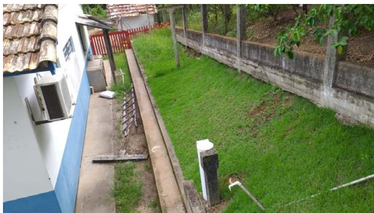
Figura 7 –Erosões e buracos rente ao muro
