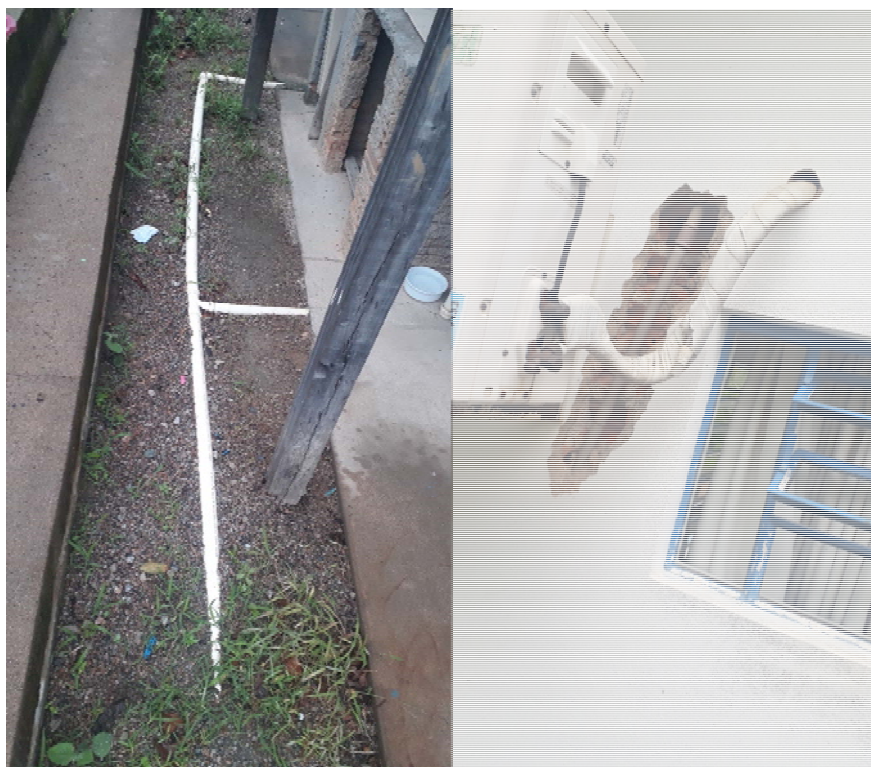
Figura 5 – Encanamento de esgoto e de água fria aparente
