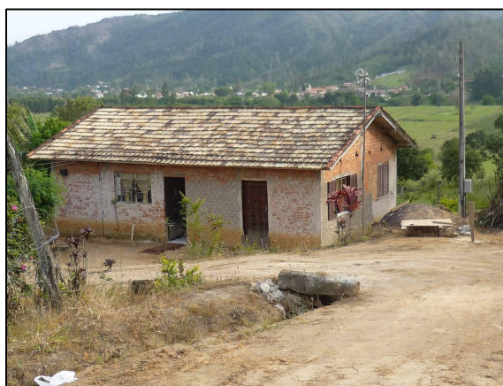
Exemplo de imóvel inacabado.
