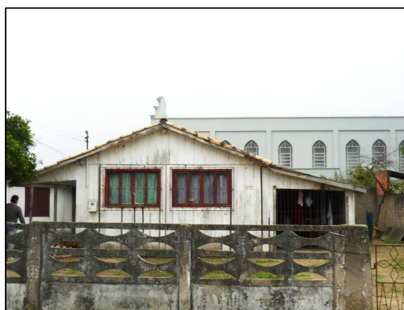
Exemplo de imóvel com necessidade de reforma.
