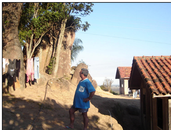
Exemplo de ocupação em área sujeita à rolamento de pedras. Loteamento Jardim Taítu, Bairro São Martinho.
